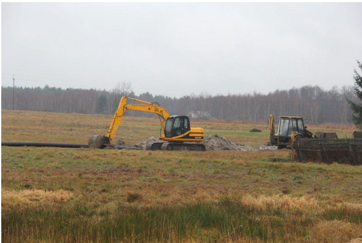
Zdjęcie. 2 Budowa odcinka sieci wodociągowej w Niwiskach
