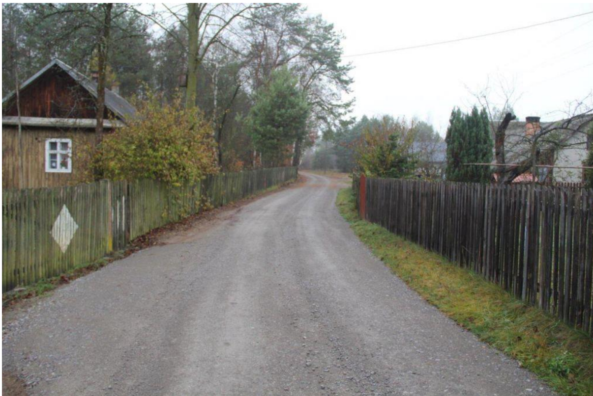
Zdjęcie. 3a Przebudowa dróg dojazdowych do gruntów rolnych: Niwiska – Hucina
