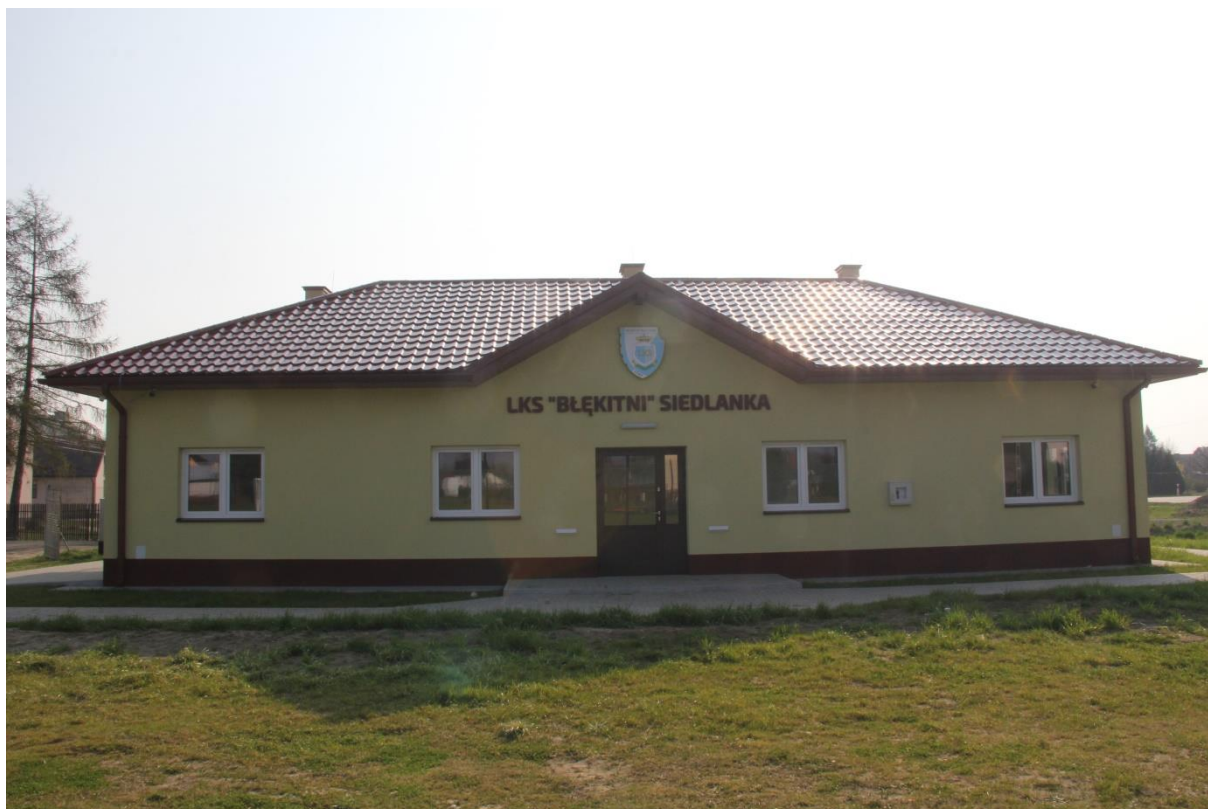
Zdjęcie 4 Budowa szatni sportowej w Siedlance
