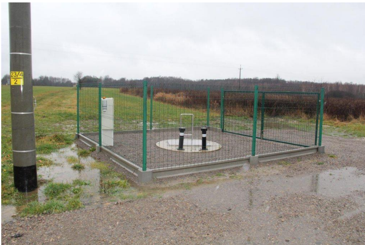
Zdjęcie. 1 Budowę kanalizacji sanitarnej w Zapolu
