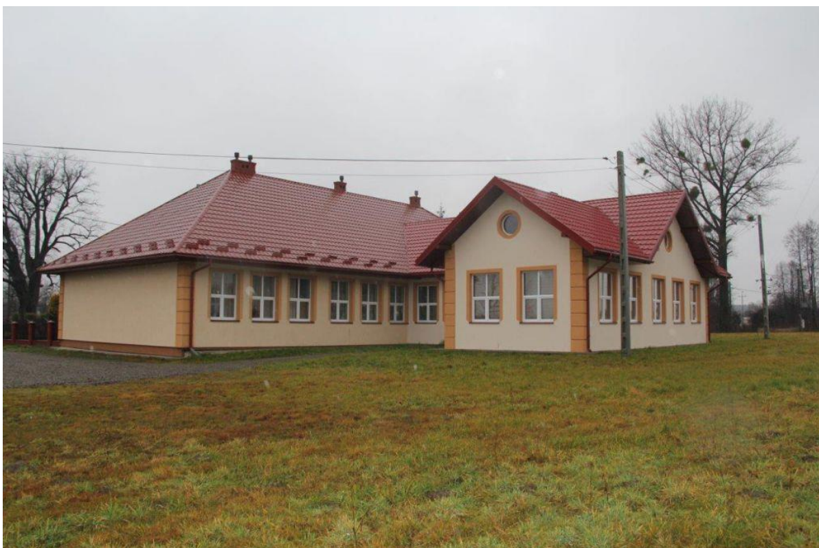
Zdjęcie 7a Rozbudowa i przebudowa części budynku Szkoły Podstawowej w Kosowach
