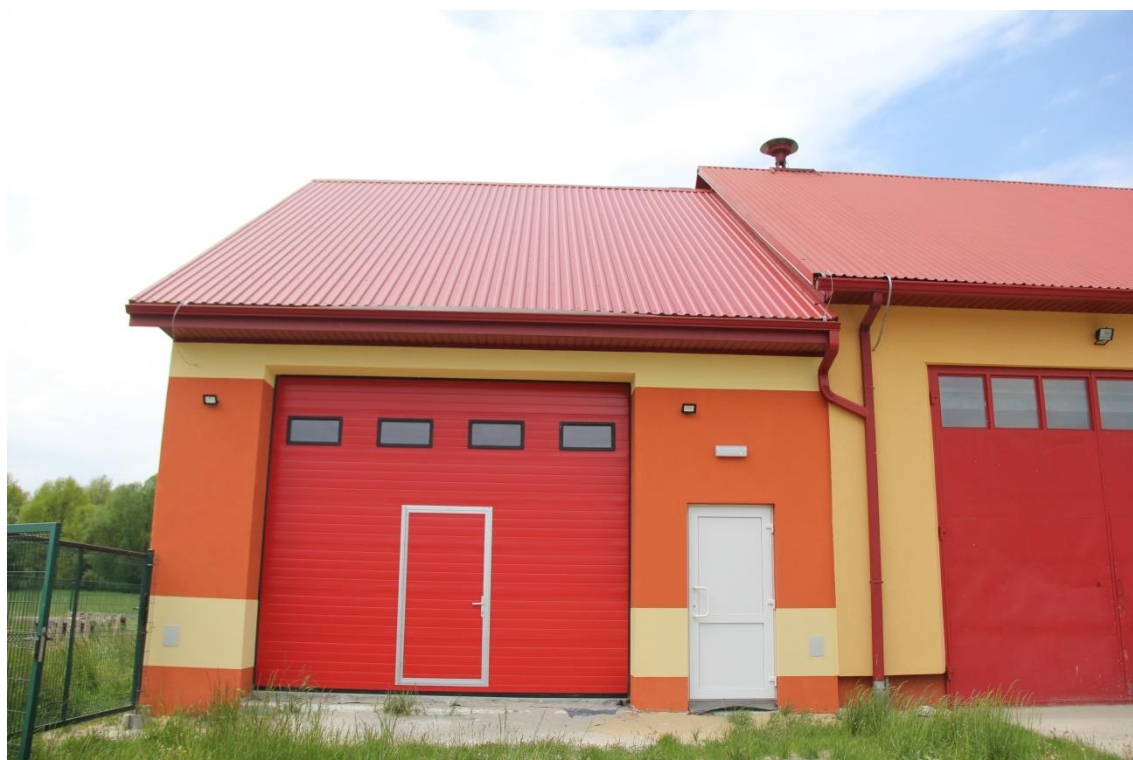
Zdjęcie. 5 Rozbudowa i przebudowa budynku remizy w Zapolu
