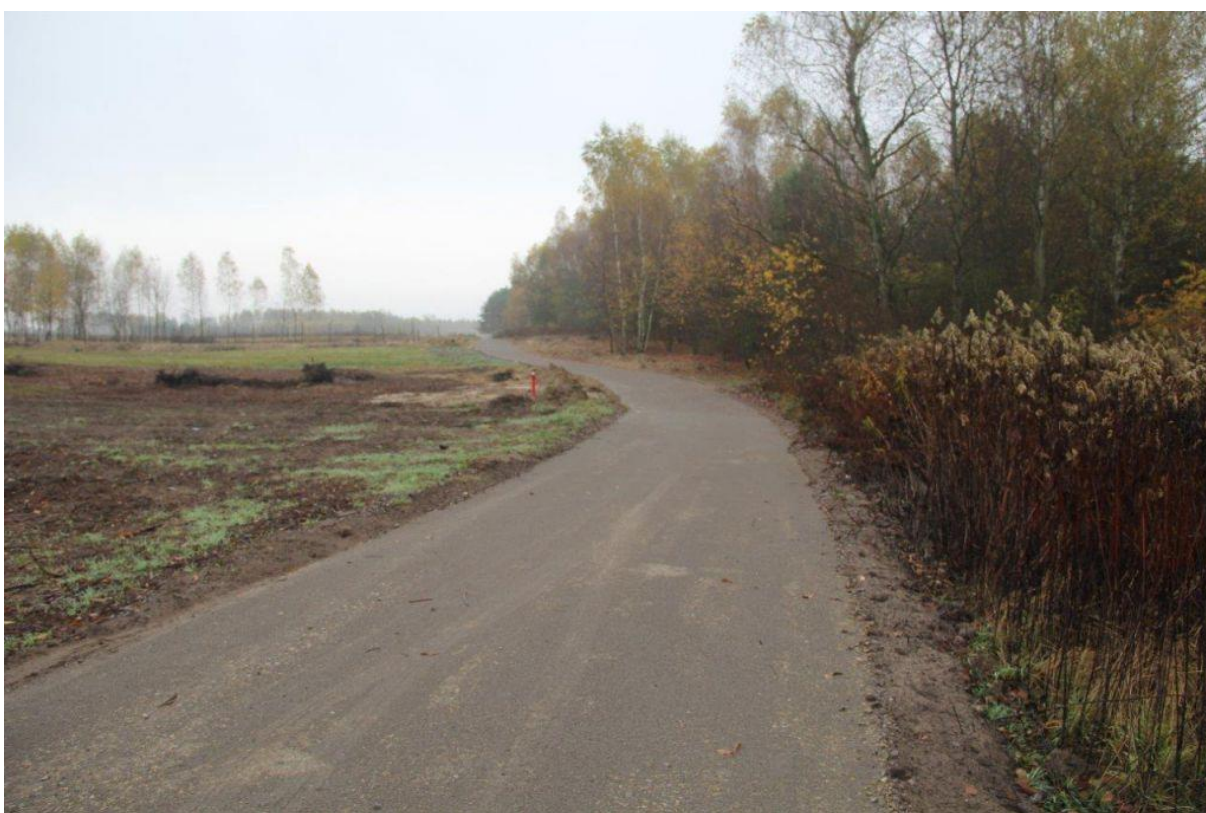
Zdjęcie. 3b Przebudowa dróg dojazdowych do gruntów rolnych: Niwiska – Hucina
